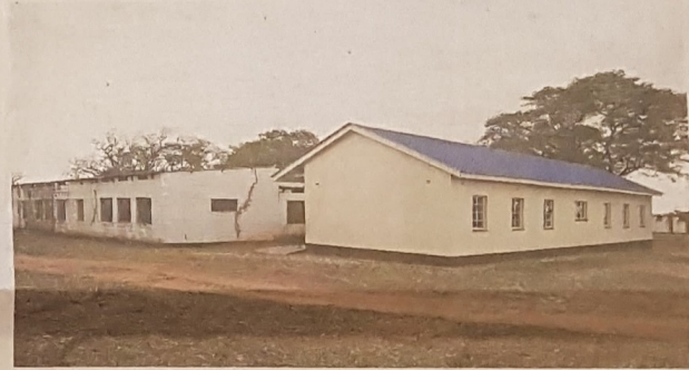
Ein Blick auf das neue Schulgebäude. Links daneben sieht man eines der baufälligen Häuser.
