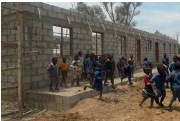
Der Rohbau der Schule in Fort Charter, ein neues Projekt des Vereins, im November 2015 fertig gestellt. Anfang 2016 kam auch das Dach drauf.
